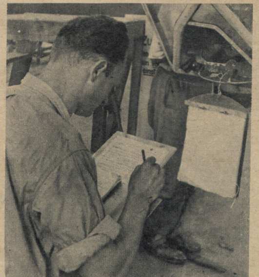
Después de un certificado de peritos sobre el avión entregado, se dispone por escrito lo que debe ser reparado o reemplazado en el aparato
