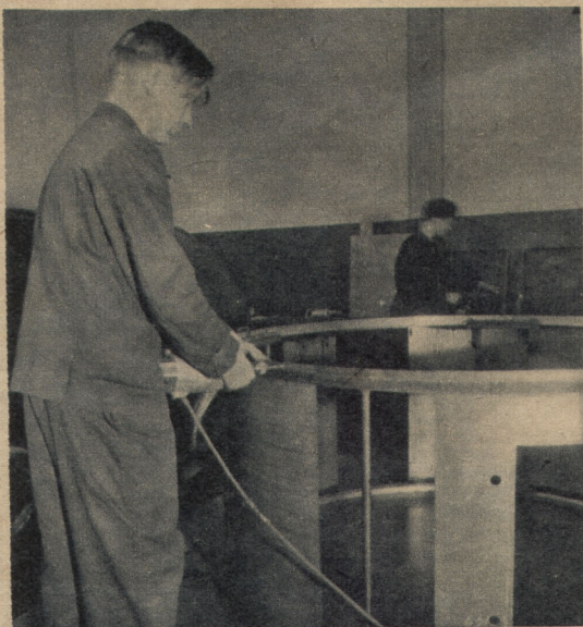
Después de forjar los aros de los reflectores y recibir su forma circular estos son soldados. Entonces se monta el armazón
